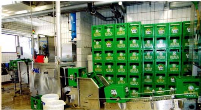
Breitstrahldüsen im Kastenwascher, versorgt mit dem ablaufenden Warmwasser der Flaschenmaschine, sorgen für saubere Gebinde
